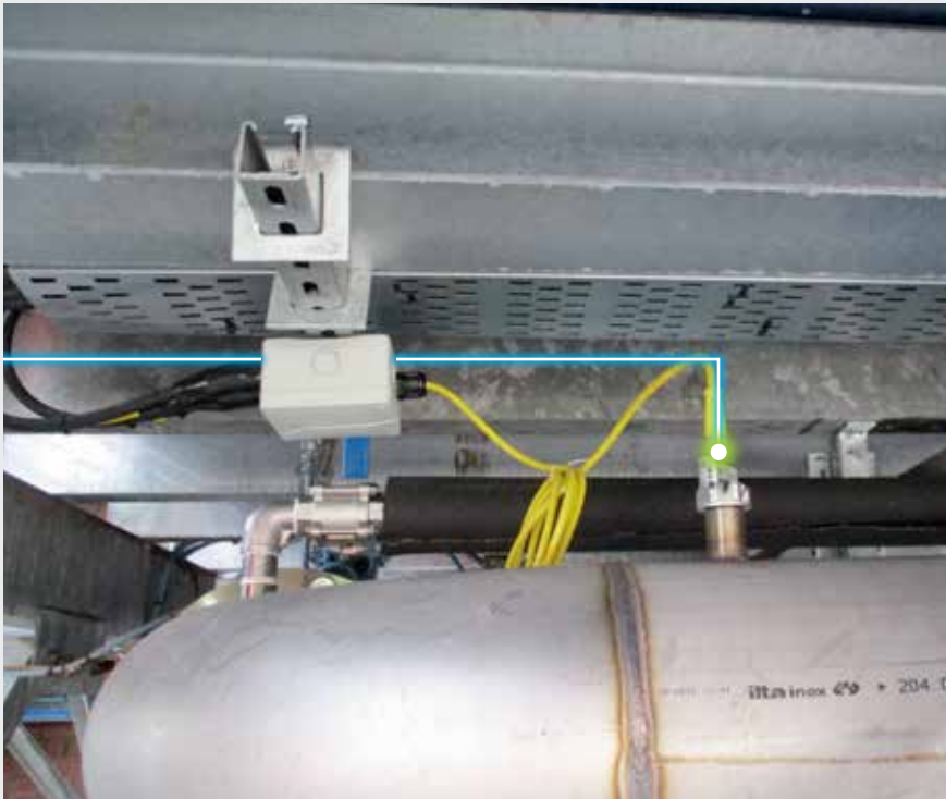
ポンプに設置されたグルンドフォス MPC コントローラによって監視される、配管の温度および圧力センサ。
