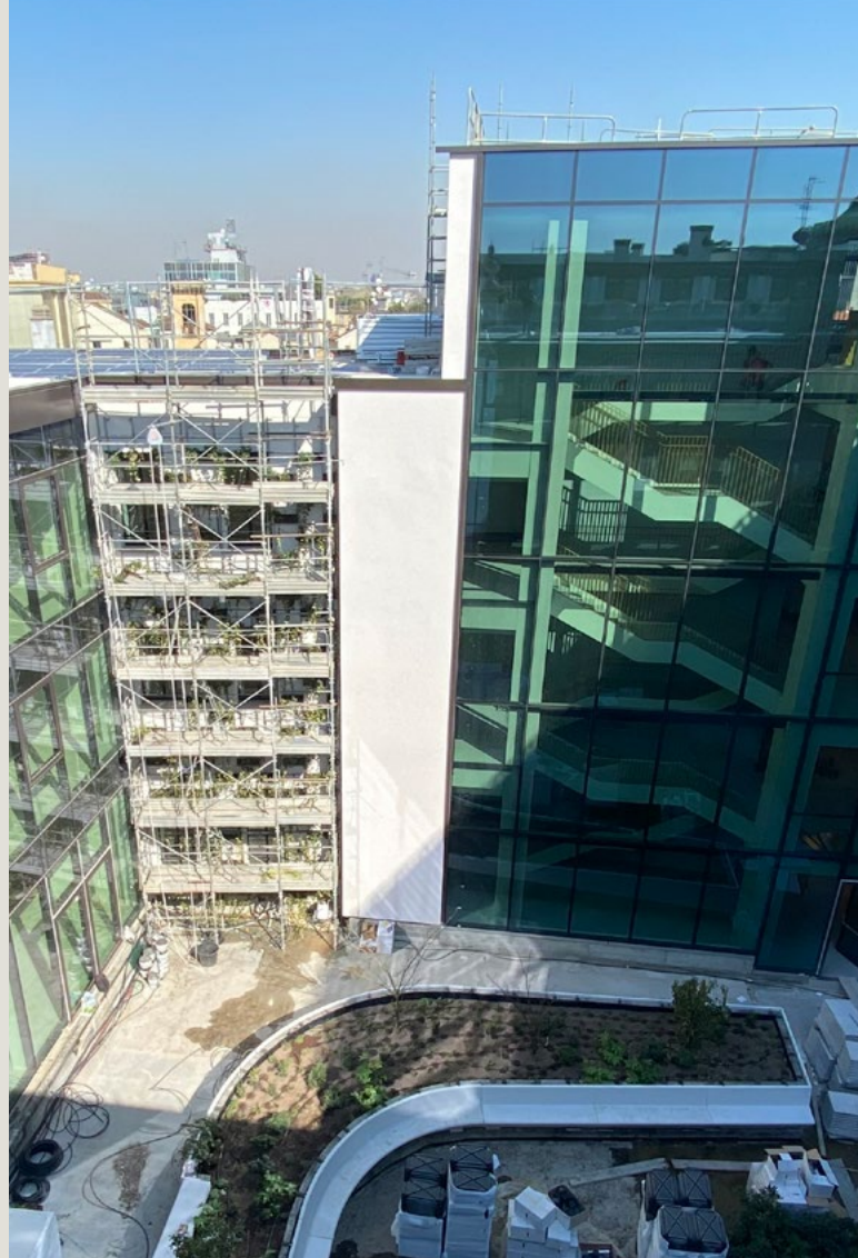
Palazzo Broggi conta numerosi piani fuori terra, perlopiù destinati a negozi e uffici.
