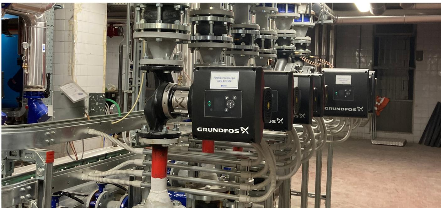
Circuito secondario del riscaldamento con pompe TPE
