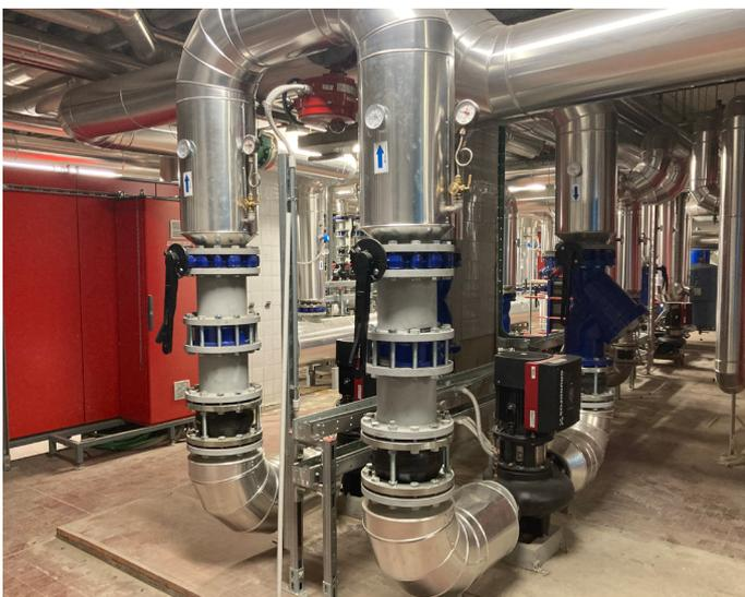
Circuito primario delle pompe di calore con pompe TPE
