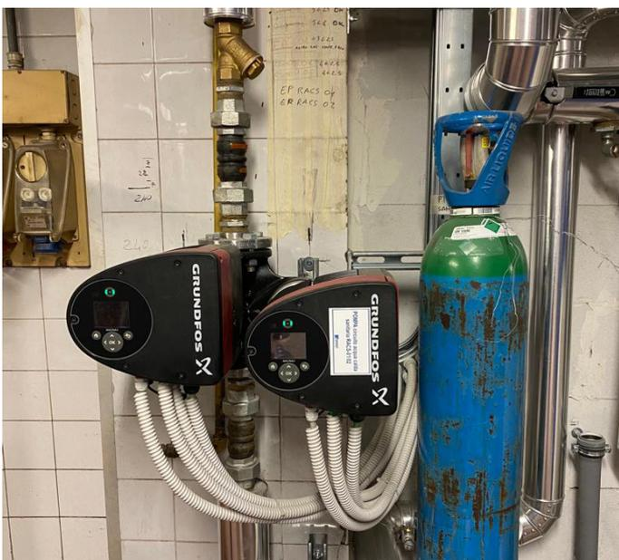
Pompa gemellare di ricircolo dell'acqua calda sanitaria, modello Magna3
