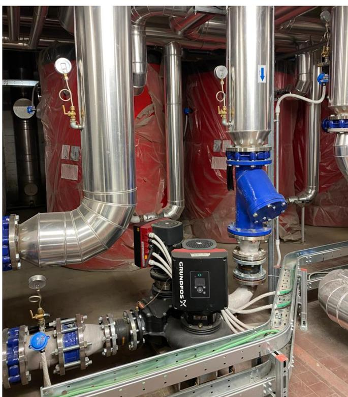
Circuito con scambiatore per l'acqua calda sanitaria con pompe TPE
