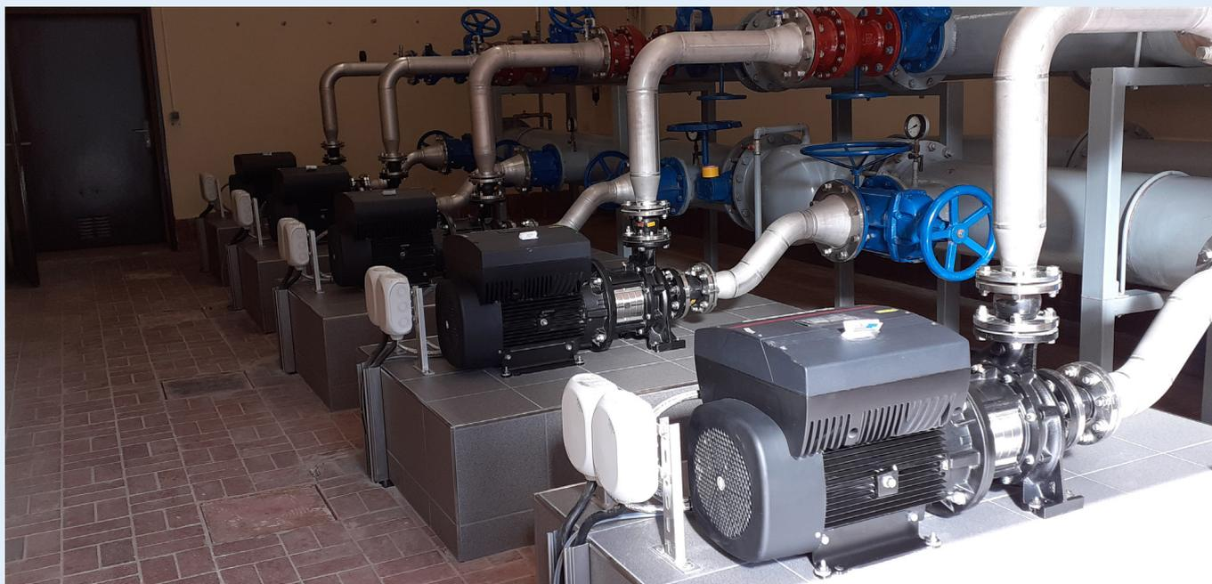
Impianto di rilancio Neustrelitz/Kiefernheide - 5 pompe a blocco NBE 65-200/198 con centralina CU 352
