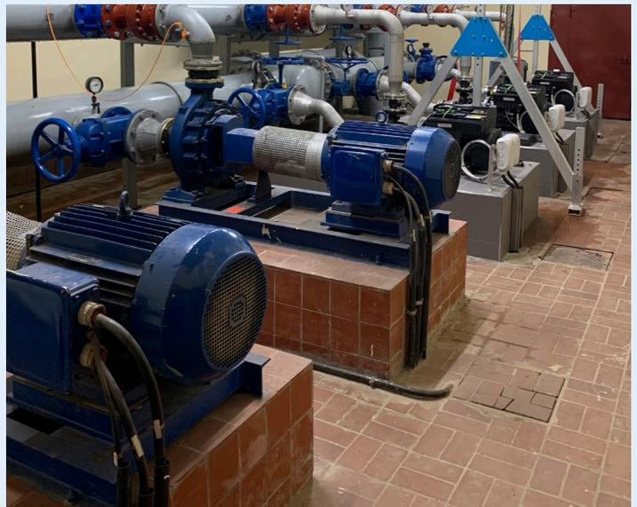
*Booster in fase di ricostruzione – vecchia tecnologia di pompa davanti, 3 nuove NBE 65-200/198 dietro (giugno 2022)*
