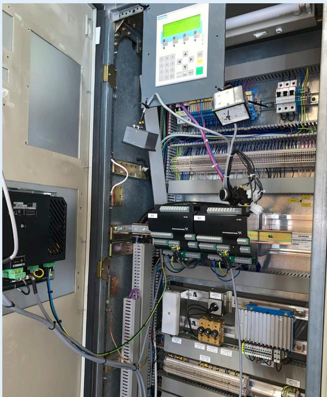
Vecchia tecnologia di controllo nell'armadio di controllo durante la fase di conversione
