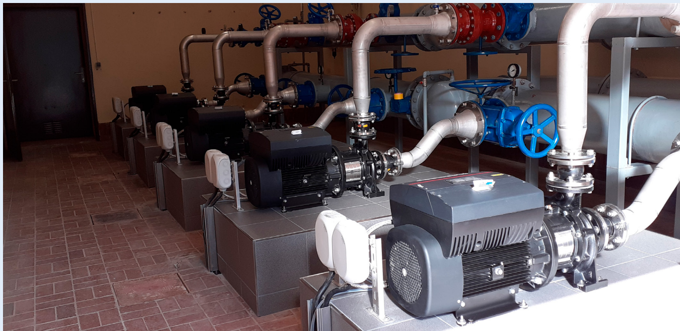
Groupe de surpression Neustrelitz/Kiefernheide - 5 pompes monoblocs NBE 65-200/198 avec coffret de commande CU 352
