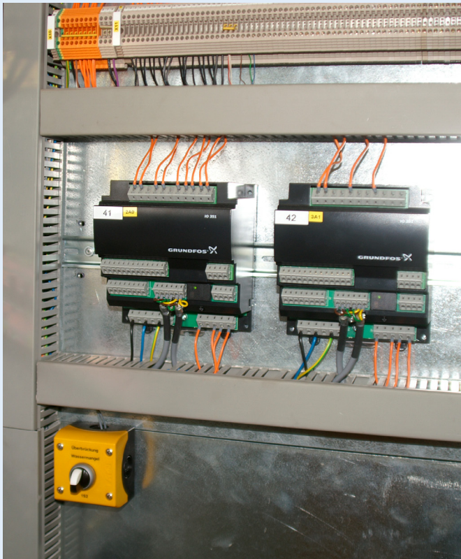
Nouveau coffret de commande CU 352 - Le groupe de surpression fonctionne parfaitement depuis le mois de juillet 2022.
