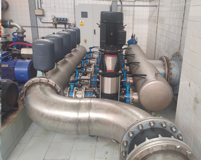
Image : (À gauche) Booster 2017 avec 4 pompes horizontales, (À droite) Nouveau système 2022 comportant 5 pompes verticales CR-125-2-1
