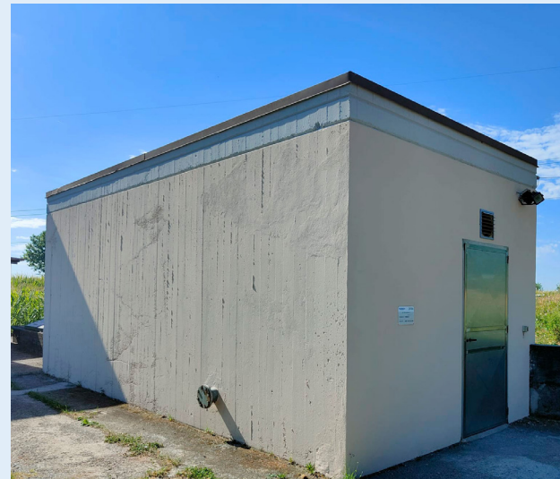
Exterior de la sala de cuadros eléctricos de la estación de bombeo de Torbole Casaglia (BS).
