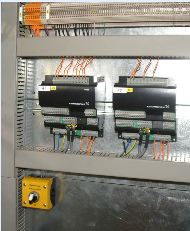
Nueva unidad de control CU 352 - El sistema de aumento de presión funciona sin fallos desde julio de 2022.
