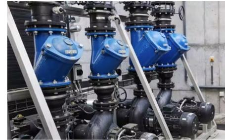
Ejemplo de instalación de una bomba Grundfos NB para el bombeo de aguas residuales industriales.
