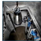
Instalación vertical sumergida en acoplamiento automático
