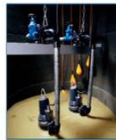
Instalación vertical sumergida en conjunto "enganchado"
