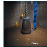
Instalación vertical sumergida en soporte de anillo
