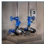
Instalación horizontal en seco
