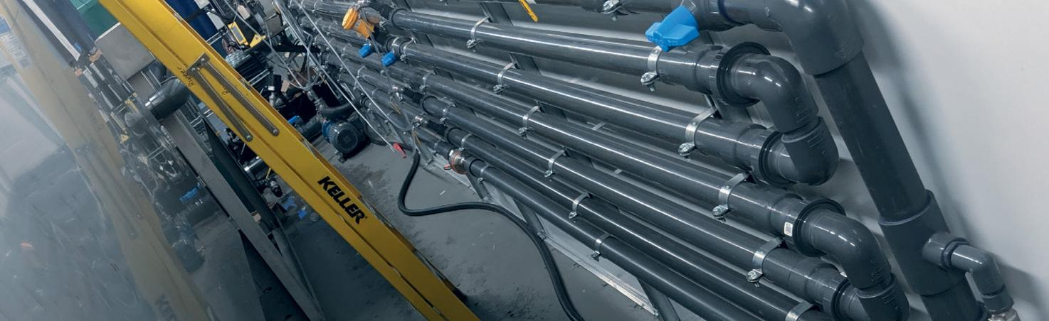
Des pompes de transfert Grundfos CM ont été installées entre le système de flottation à air dissous et le réservoir de mélange de pH. Une pompe Grundfos CRE a été installée pour réaliser la filtration et une paire de pompes Grundfos CRE a été installée en guise de pompes de lavage à contre-courant en raison de la large plage de débits et de pressions disponibles.
