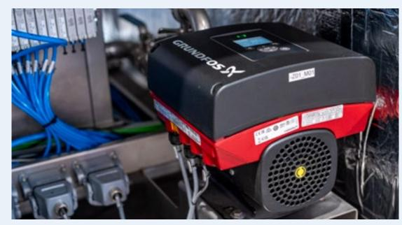
Con una E-pump Grundfos, la pressione viene gestita direttamente tramite il pannello di controllo della pompa, mostrato a sinistra. Non è necessario un VFD esterno in un armadio di controllo e, a destra, sono mostrate due pompe CME compatte installate in un sistema di prova.
