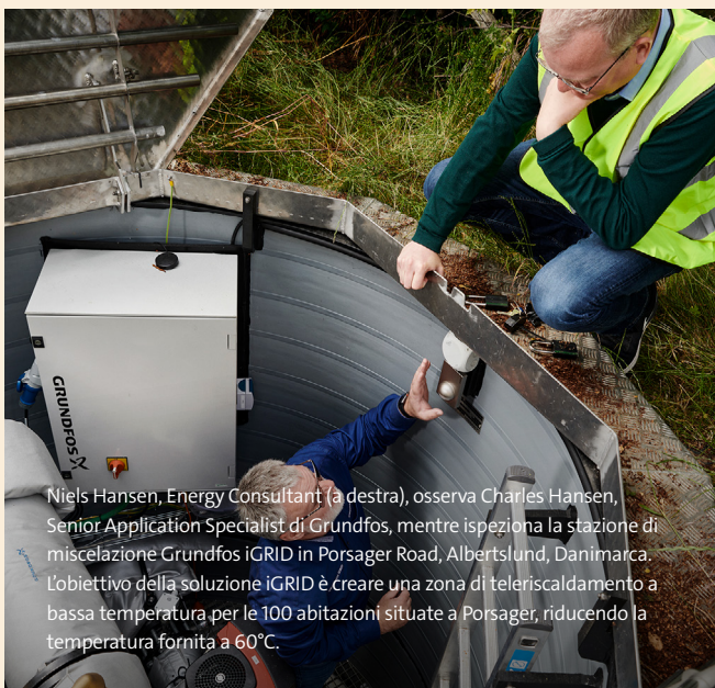
Una delle stazioni di miscelazione in superficie che Albertslund Forsyning utilizza per creare una zona a bassa temperatura in un'area residenziale.
