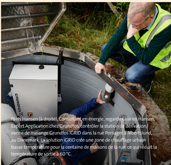
L'un des shunts hors-sol, de conception propre, qu'Albertslund Forsyning utilise afin de créer une zone basse température dans un quartier résidentiel. Le service de chauffage urbain apprécie la solution souterraine de Grundfos iGRID, notamment parce qu'elle n'est pas visible.
