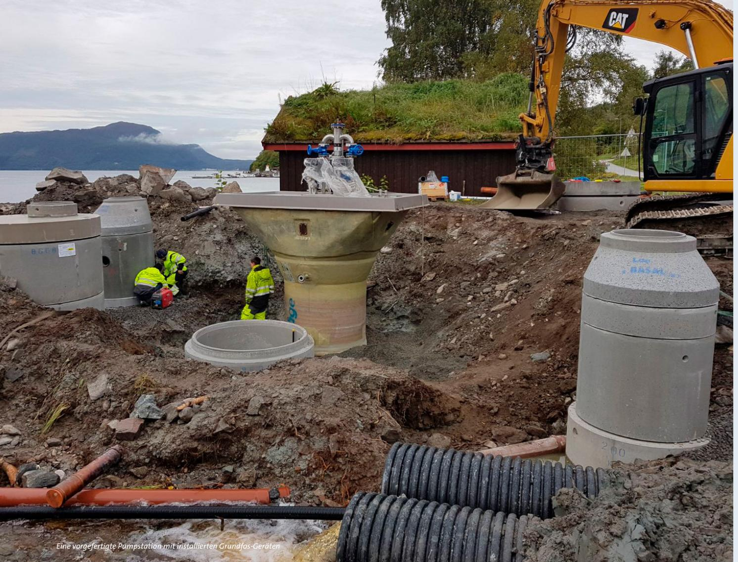
Eine vorgefertigte Pumpstation mit installierten Grundfos-Geräten
