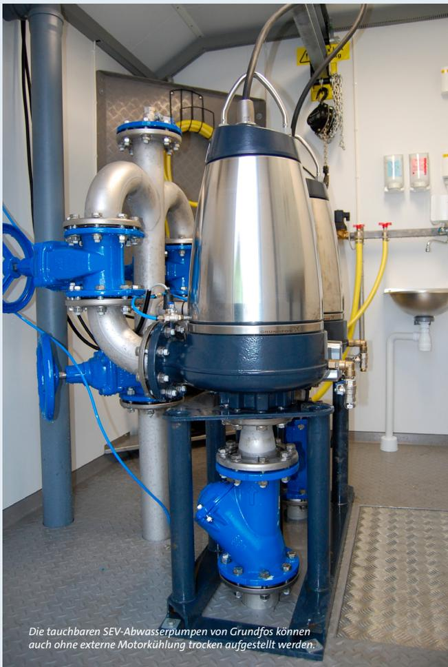
Die tauchbaren SEV-Abwasserpumpen von Grundfos können auch ohne externe Motorkühlung trocken aufgestellt werden.
