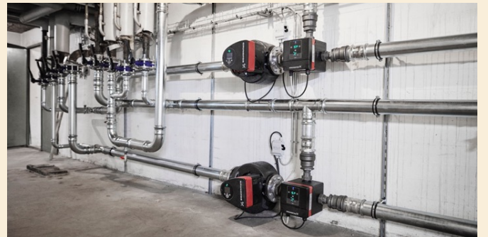
Envases'te Grundfos MIXIT ve MAGNA3 ile yeni kurulmuş iki karıştırma devresi.
