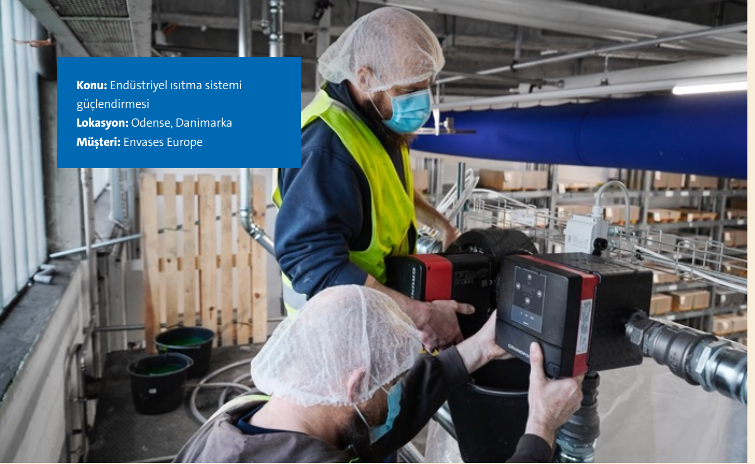
Envases HVAC sistemi için MAGNA3 sirkülasyon pompası ile MIXIT ünitesinin kurulması.
