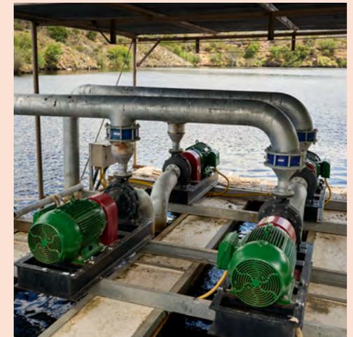
Las bombas de aspiración axial Grundfos NK 65-250 transportan el agua desde uno de los principales embalses del río hasta una represa situada a medio camino del terreno montañoso de la finca. Funcionan desde una estructura flotante en el lago.
