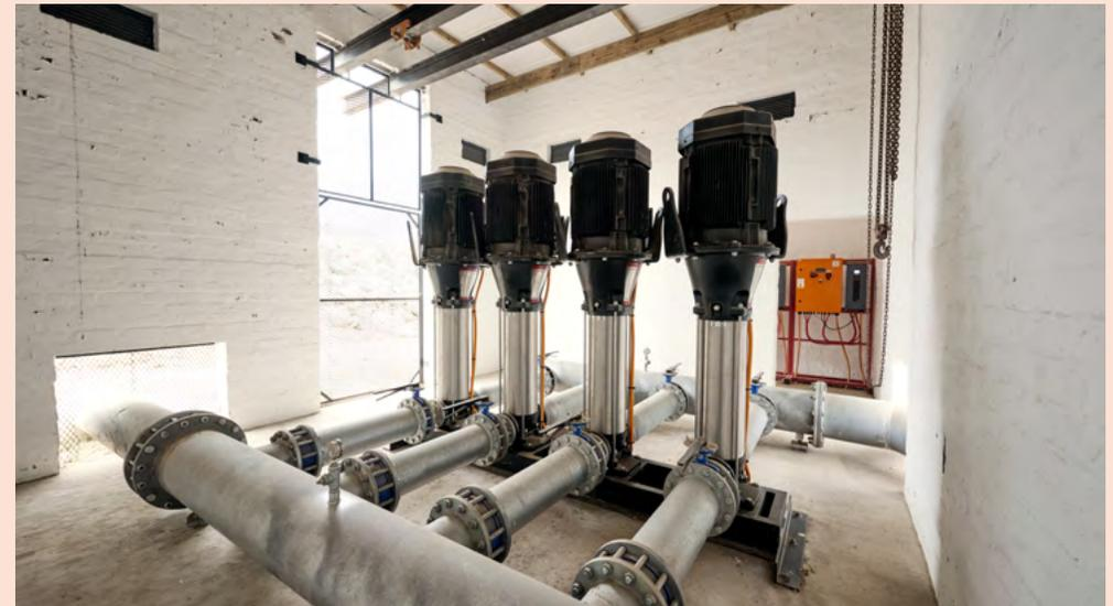
Un sistema de aumento de presión Grundfos CR. Al fondo, junto al armario de alimentación de CA/CC naranja, hay un inversor solar Grundfos que convierte la corriente continua de la energía solar en corriente alterna para las bombas. Si no hay suficiente corriente continua (CC), la unidad pasa a la corriente alterna (CA) de la red.
