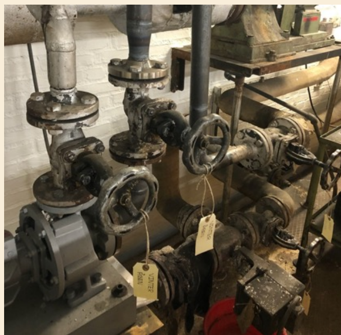
Um circuito de mistura da Envases antes da reconversão para o MIXIT.
